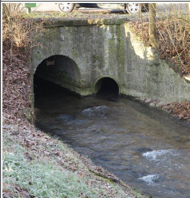
Alte Oesch, Durchlass beim Dorfausgang Deitingen
