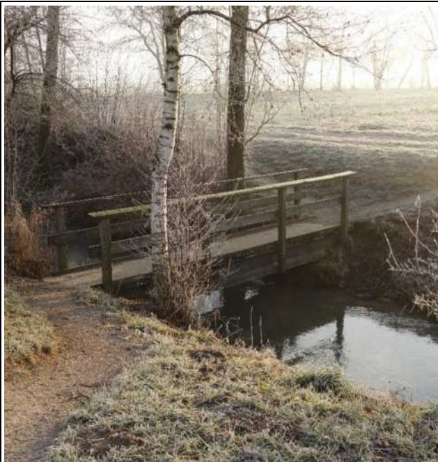
Alte Oesch, Brücke bei Kantonsgrenze SO/BE
