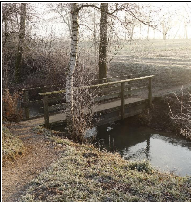
Alte Oesch, Brücke bei Kantonsgrenze SO/BE
